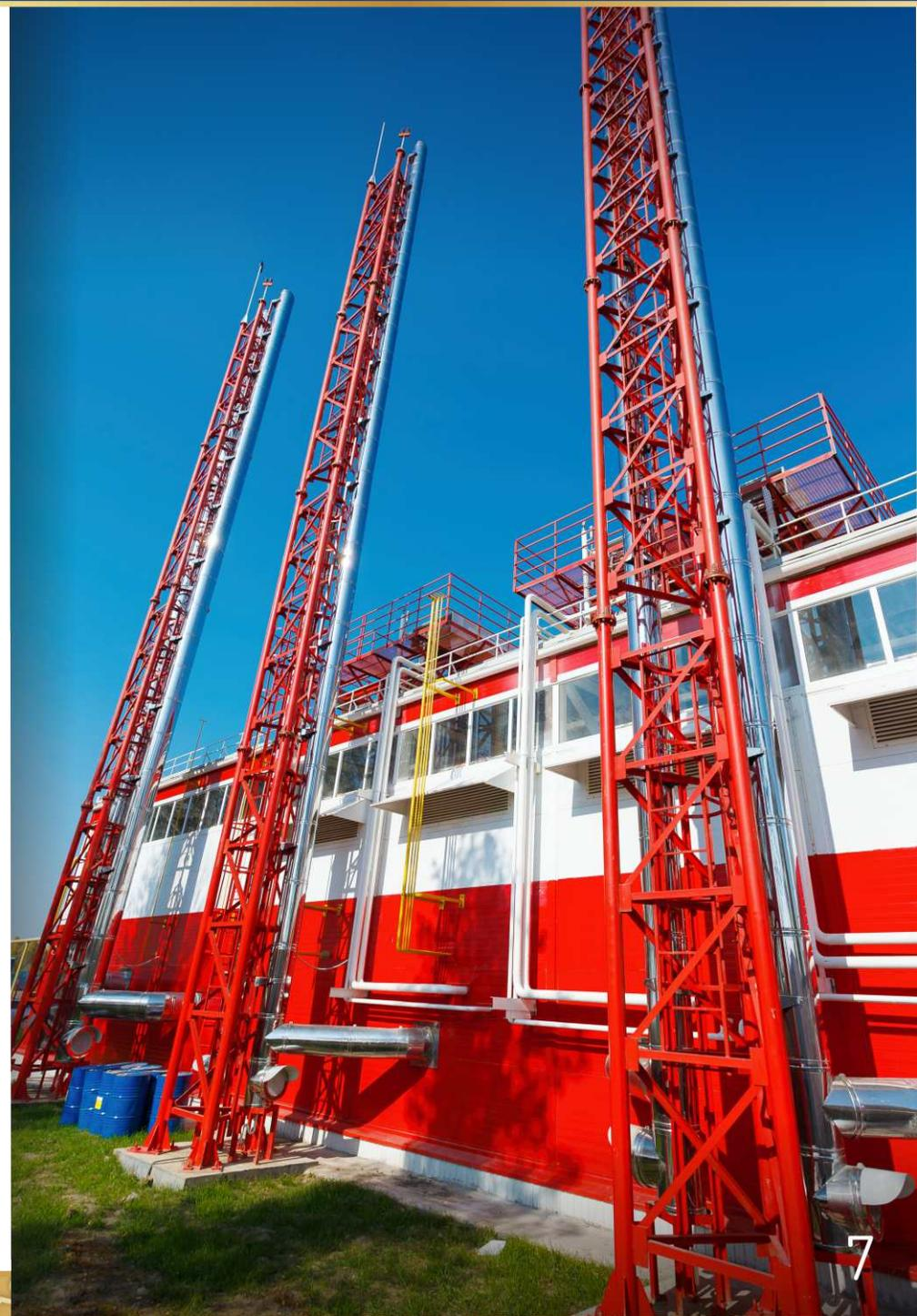
Газопоршневые установки (ГПУ) - представляет собой двигатель внутреннего сгорания с внешним смесеобразованием и искровым зажиганием горючей смеси в камере сгорания. ГПУ использует в качестве топлива газ. Утилизация тепла происходит посредством теплообменника, что обеспечивает повышение общего КПД установки
