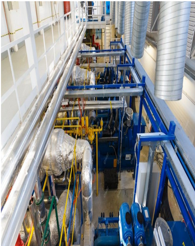
Строительство мини-ТЭС «под ключ»
