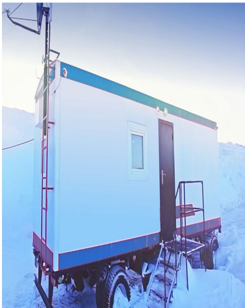
фото вагон-дом электростанции
