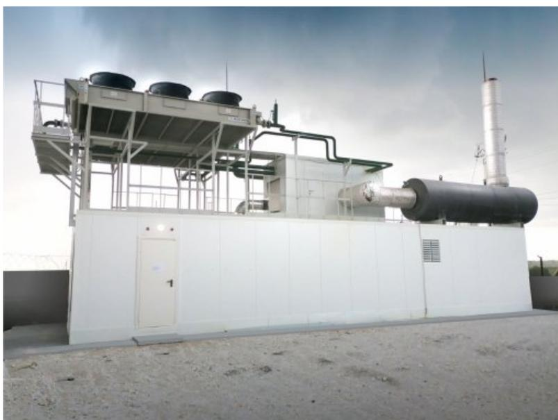
**Группа компаний «МКС» ввела в эксплуатацию энергоцентр в Карталинском районе Челябинской области. Блочно-модульная электростанция мощностью 2 МВт будет снабжать доступной электроэнергией и теплом крупнейшее предприятие по добыче и обработке природного камня в России. Примечательно, что это уже второй энергообъект для данного заказчика, что еще раз подтверждает долгосрочный характер сотрудничества с командой МКС.**
