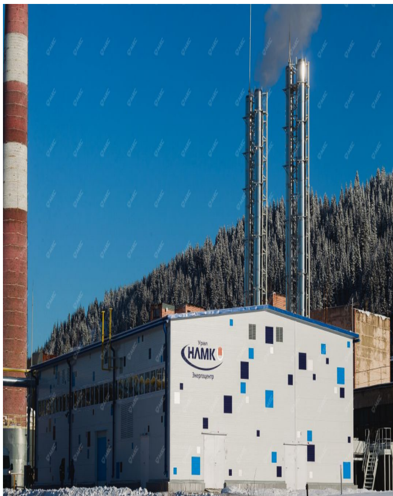
энергоцентр производства группы компаний МКС для завода НЛМК Ревда
