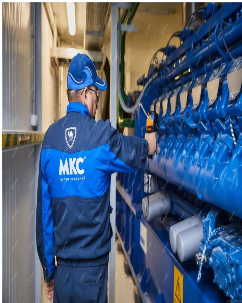
сотрудник группы компаний "МКС" измеряет температуру линии отводящих газов двигателя MWM при помощи тепловизора
