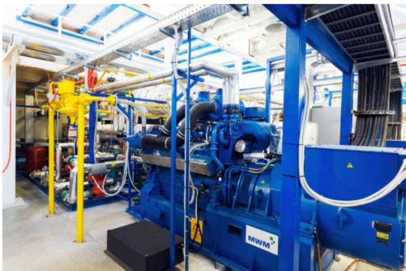
После завершения строительно-монтажных работ на одном из стратегически важных объектов компании - «ПРОЕКТЕ-2» - и тестового запуска электростанции на холостом ходу, на этой неделе инженеры «МКС» приступили к проведению пусконаладочных работ под нагрузкой. В настоящий момент специалисты департамента сервиса проверяют работу всех систем энергоцентра, отлаживают тепловые режимы, в целом готовят объект к полноценной работе.
