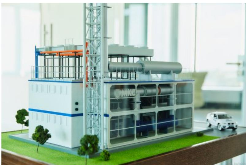
**Уникальная разработка Группы компаний «МКС» — блочно-модульная электростанция на базе газопоршневых двигателей MWM TCG 2032B (4,5 МВт) — теперь визуализирована и в архитектурном макете.**
