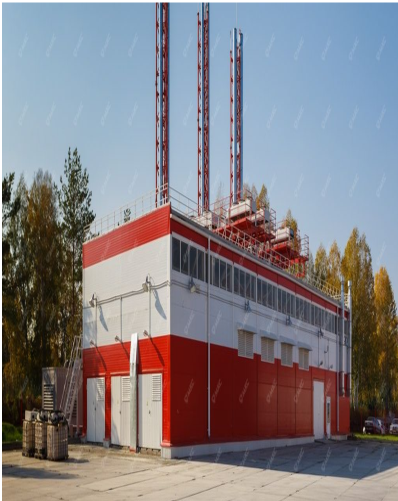
Пример стационарной электростанции производства Группы компаний «МКС»
