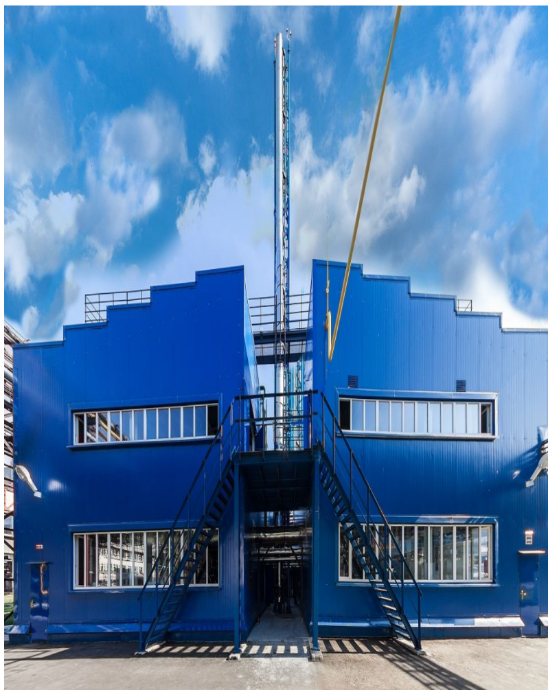
Тригенерационный энергоцентр комбината химической продукции АО «Пигмент»
