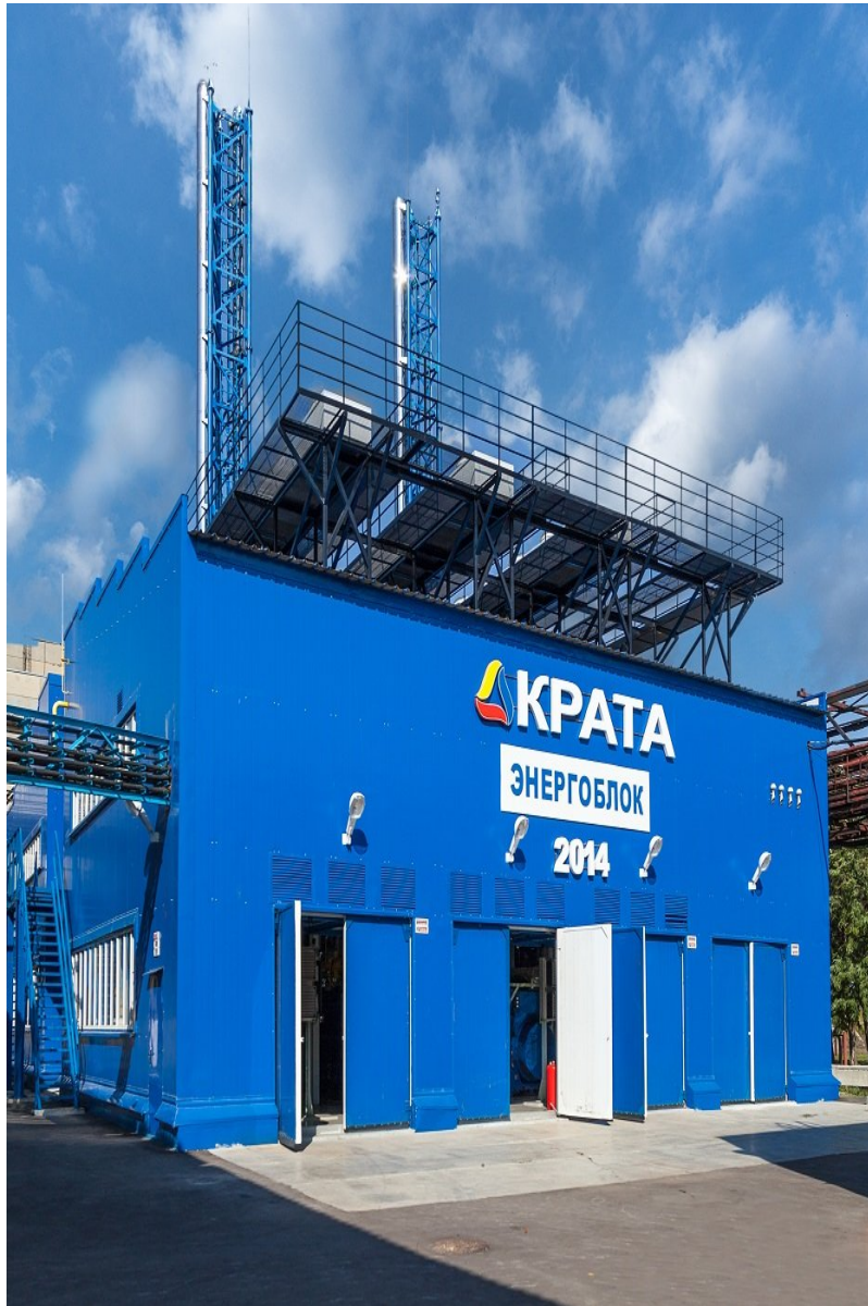
Тригенерационный энергоцентр комбината химической продукции АО «Пигмент»
