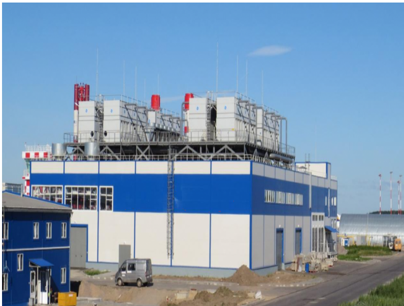
Энергетический центр аэропорта «Пулково» (Санкт-Петербург)
