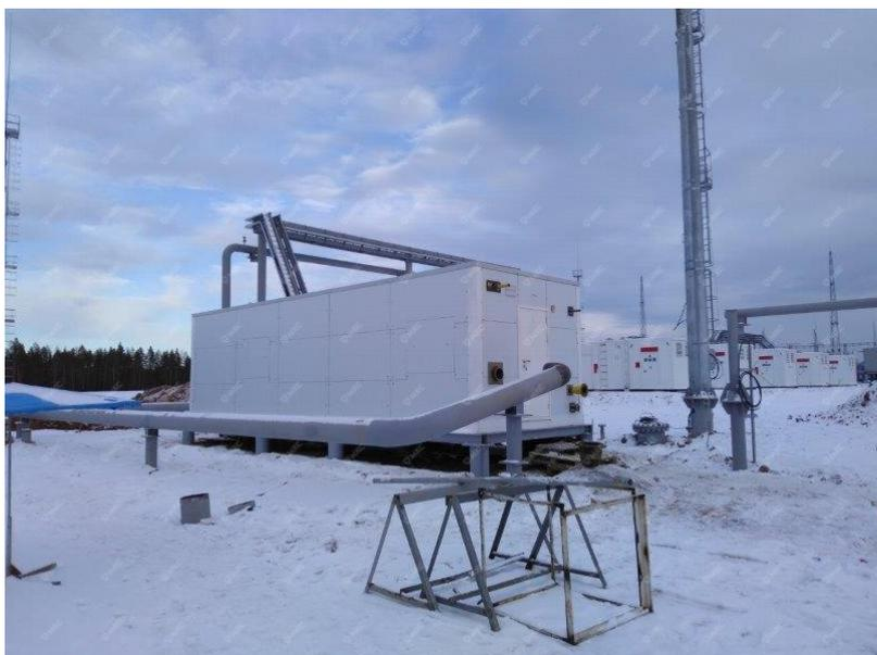
Данный проект был реализован «под ключ», начиная от проектирования, производства и завершая пусконаладочными работами. На производственной площадке в Челябинске были изготовлены два инновационных устройства: установка подготовки топливного газа (УПТГ) и емкость для сбора конденсата. Данные объекты, предназначенные для переработки попутного нефтяного газа, в настоящий момент используются в общей энергосистеме месторождения, на площадке которого был запущен новый энергоцентр.
