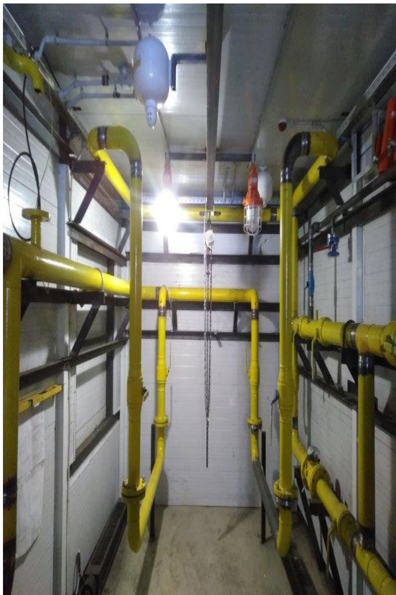
установка по подготовке топливного газа от Группы компаний «МКС»
